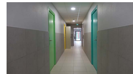
Couloir intérieur bâtiment Tanargue
