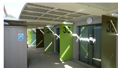
Couloir extérieur bâtiment Gournier
