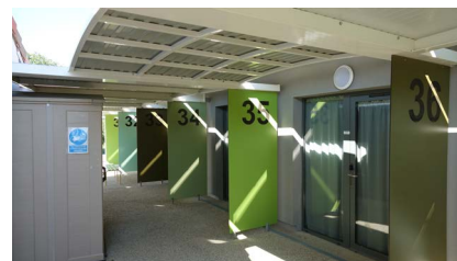
Couloir extérieur bâtiment Gournier
