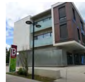
Site de Voiron, implanté sur le Campus de la Brunerie
