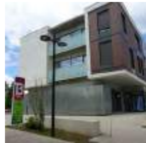
Site de Voiron, implanté sur le Campus de la Brunerie
