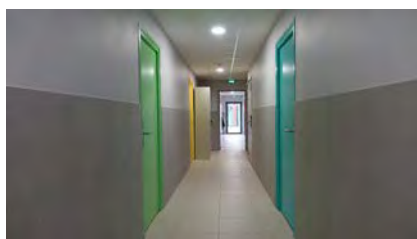
Couloir intérieur bâtiment Tanargue
